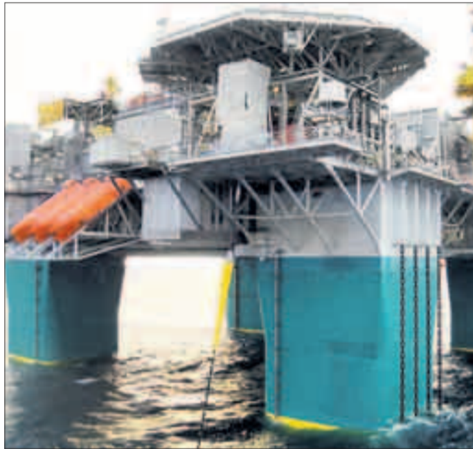
KONTAKT 1: Gjøa-plattformen utanfor Sogn er elektrifisert og fekk i juli halt om bord kabela frå Mongstad, tre månader før produksjonsstart.
